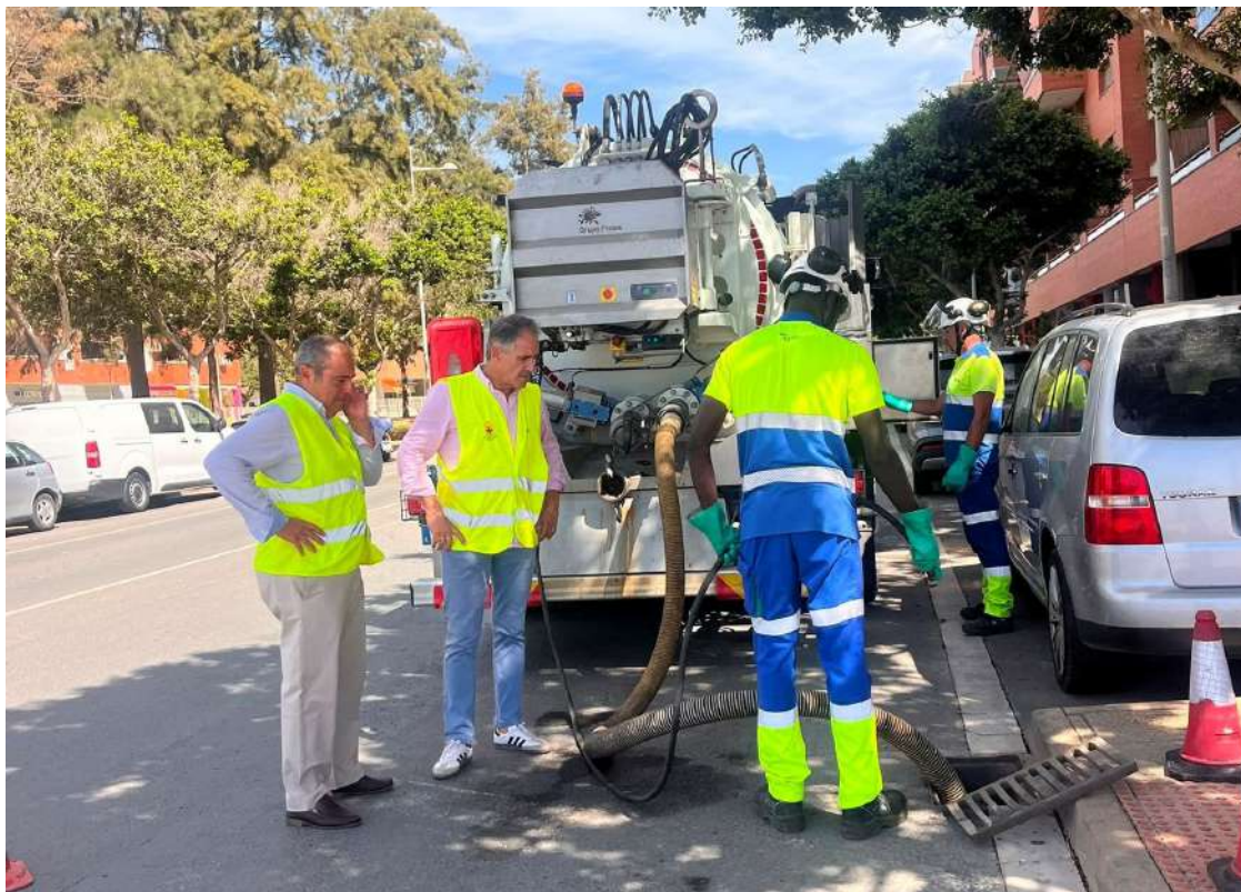
Juanjo Segura, en una visita a los trabajos de limpieza de los imbornales.
