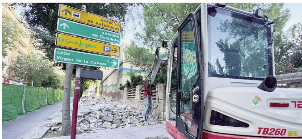
Inicio de las obras en la Avenida de Madrid. AYUNTAMIENTO
