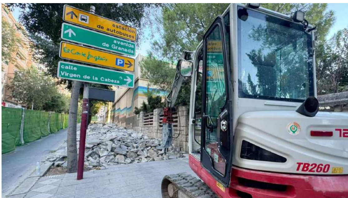
Inicio de las obras en la Avenida de Madrid. / Ayuntamiento de Jaén
