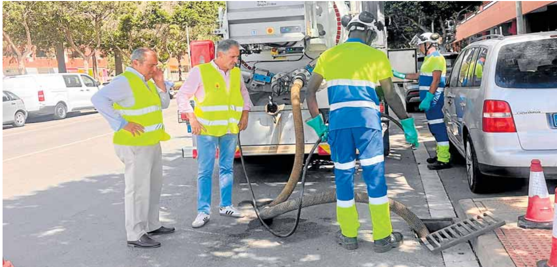
Operarios de Aqualia trabajan en la limpieza de los imbornales en presencia del concejal de Agua y Medio Ambiente, Juanjo Segura. IDEAL
