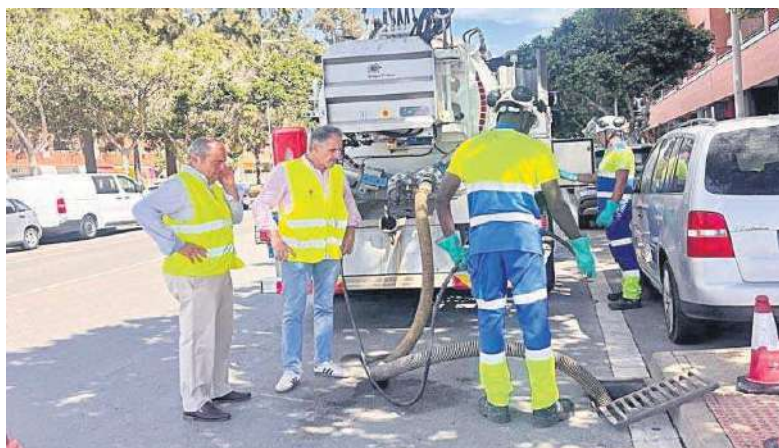
Juanjo Segura, en una visita a los trabajos de limpieza de los imbornales.
