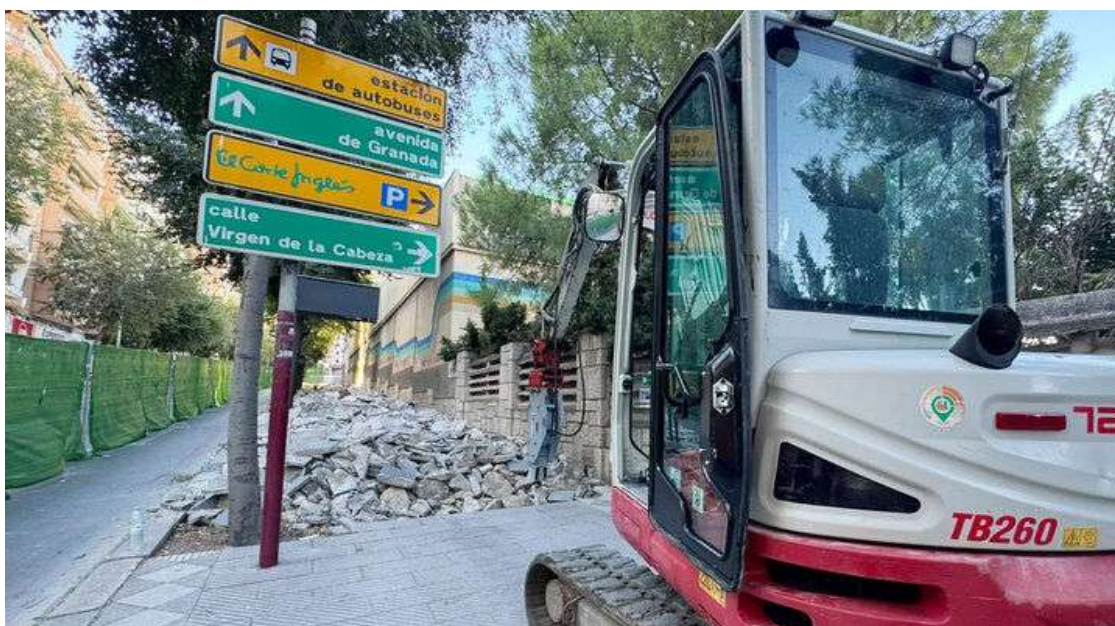
Inicio de las obras en la Avenida de Madrid. Foto: Ayuntamiento.
