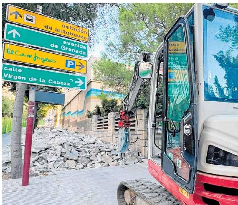
Inicio de las obras en la acera más próxima al colegio Maristas. IDEAL
