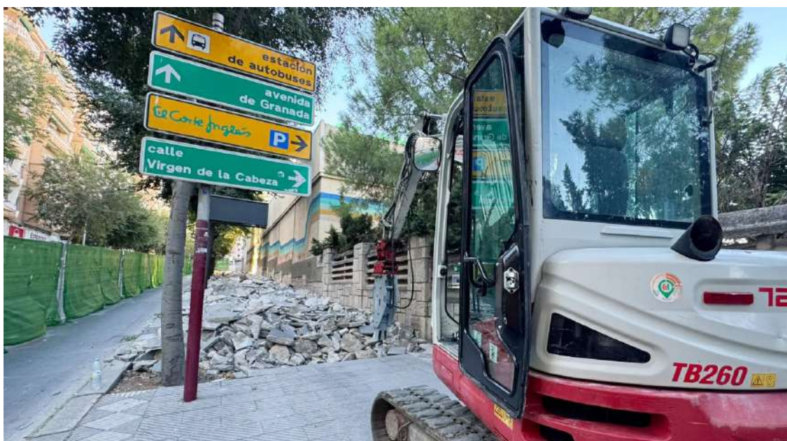
Inicio de las obras de Avenida de Madrid.
