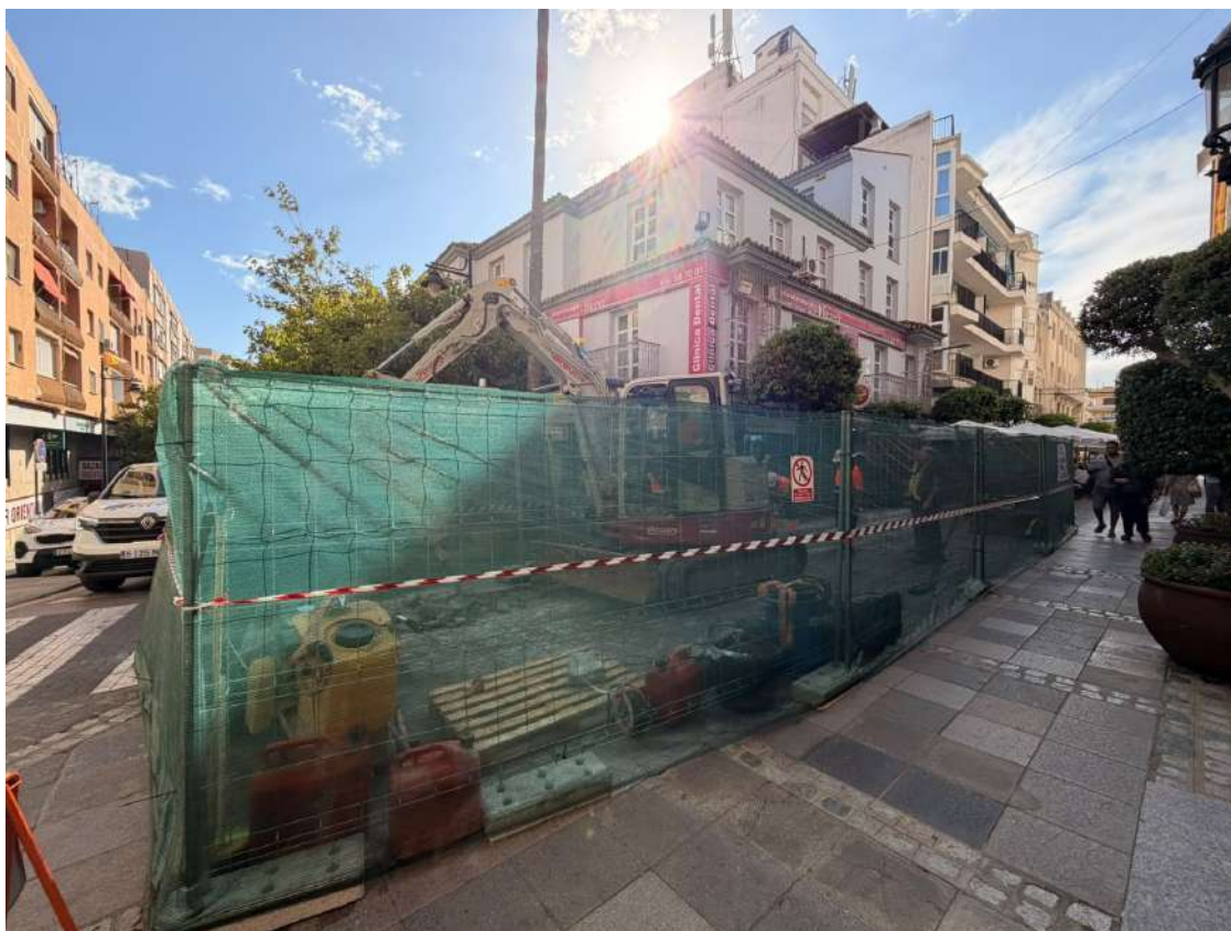
La intervención de Emalgesa en la calle Alfonso XI a la altura del edificio consistorial.
